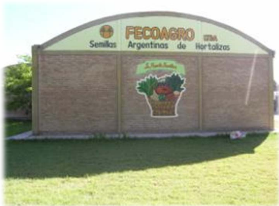
Fachada de la Sede Central de FECOAGRO. Departamento de Santa Lucía, San Juan.
