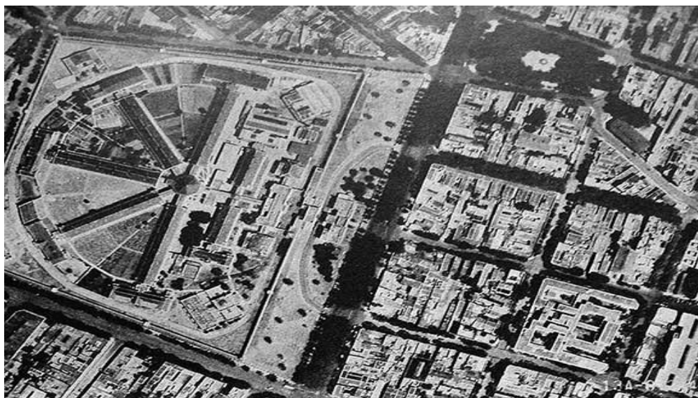
Foto 1. Barrio de Palermo. Vista aérea de la Penitenciaría Nacional. Fuente: Revista La Ingeniería Nro. 77, 2/2/1939.
