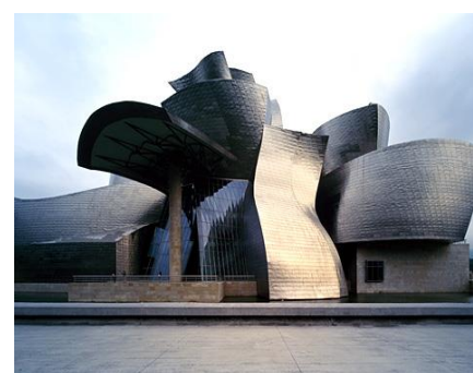
Detalle del sector con piel metálica de titanio
