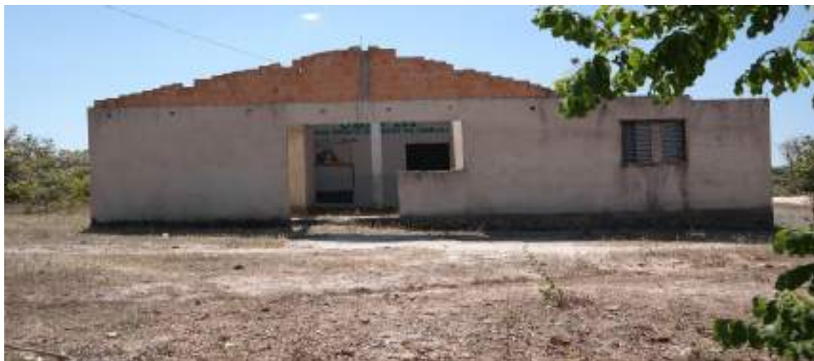
Figura 54 - Unidade Básica da Família III –USF III- (em reforma) Comunidade Quilombola-Kalunga-Engenho II- Cavalcante de Goiás
