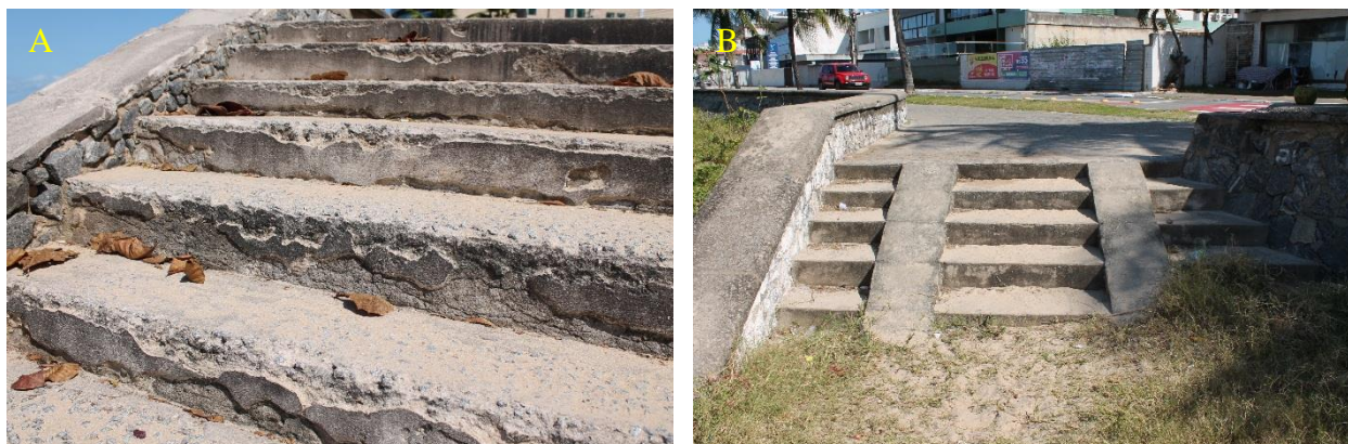
Figura 9 Acessos até a faixa de areia da praia de Manaíra. Nota: (A) Detalhe demonstrando o estado de conservação das escadarias que dão acesso à faixa de areia. (B) Adaptação da escada para acesso de veículos à faixa de areia. Fonte: Arquivo próprio.
