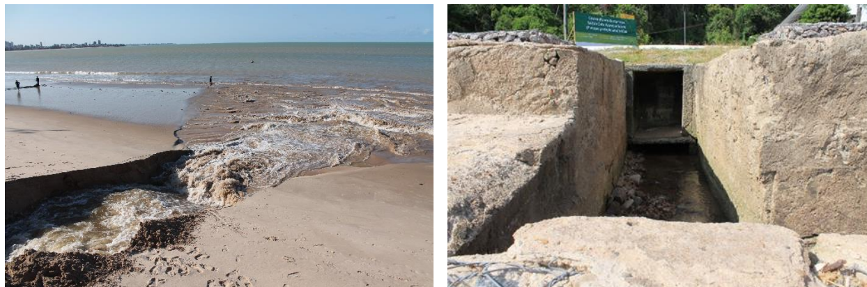
Figura 41 Emissários de águas pluviais potencialmente contaminados nas praias de Manaíra (A) e Cabo Branco (B). Fonte: Arquivo próprio.
