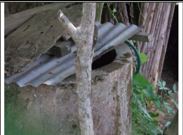
Registro Fotográfico: Almacenamiento de Agua para Consumo-Subregión Sinú Medio departamento de Córdoba.
