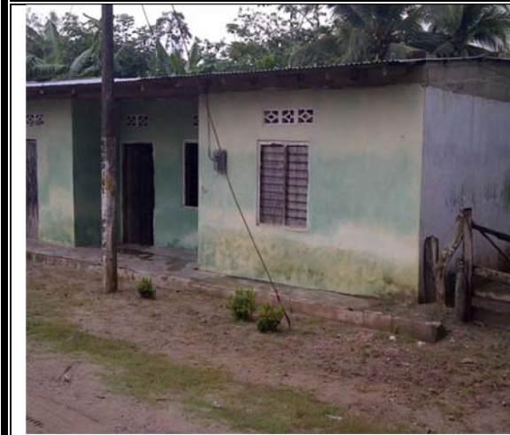
Registro Fotográfico: Tipo de Vivienda Subregión Sinú Medio departamento de Córdoba.
