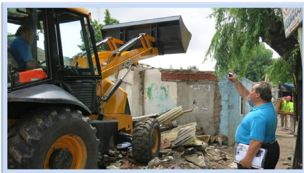
Foto Nº 12: Demolición de las viviendas ubicadas en el camino de Sirga.
