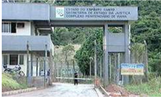
Figura 36: fotos de la parte externa del Complejo Penitenciario de Viana, Espírito Santo – Brasil. Fuente: fotógrafo desconocido 36 .
