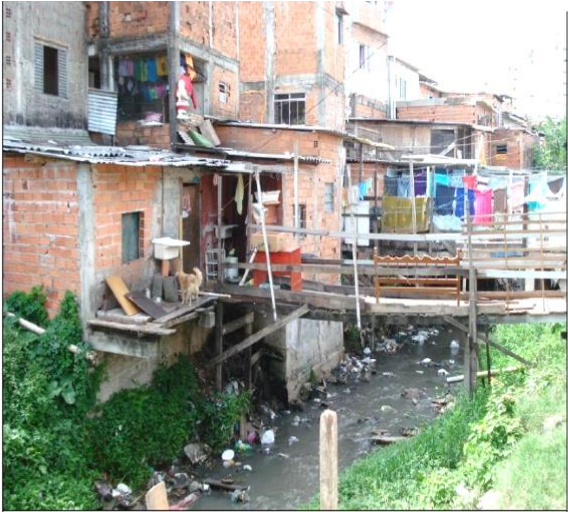
Figura 11 - Foto realizada en trecho del Arroyo Mirassol clasificado como área con grado de riesgo alto (R3). Fuente: Relatório Técnico Nr 119.614-205 (2010), p. 71. Instituto de Pesquisas Tecnológicas [IPT] São Paulo.
