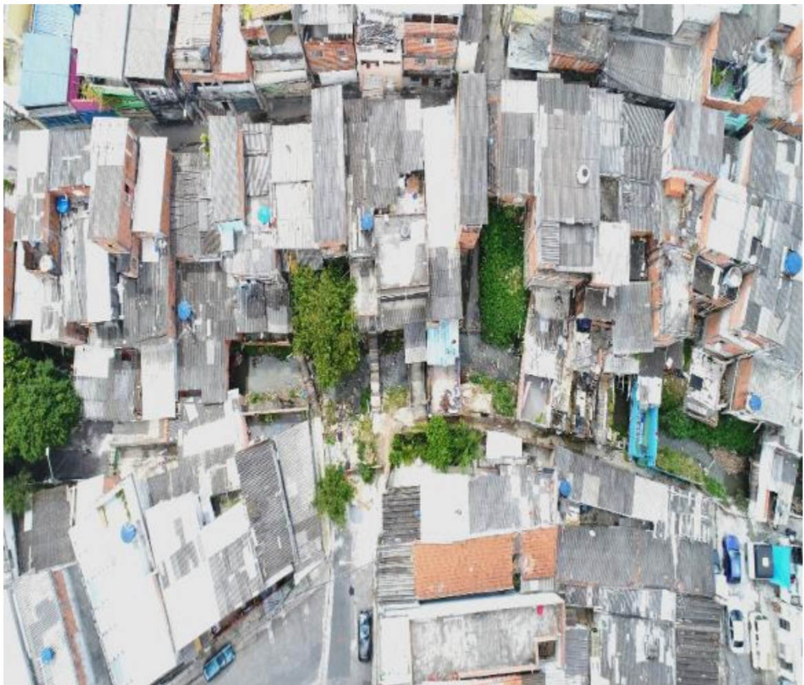
Figura 8 - Foto aérea de viviendas construidas sobre el lecho del Arroyo Mirassol . Fuente: Foto aérea ejecutada por Drone Modelo Phantom IV.- Foto: Coordenadoria de Defesa Civil de São Paulo (2018).
