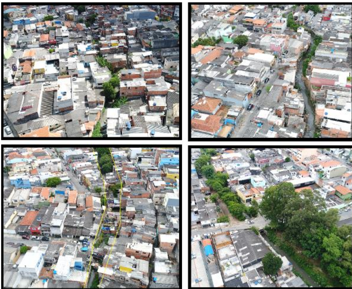
Foto 6: Avanzo de la urbanización al Arroyo Mirassol . Fotos: Coordenadoria de Defesa Civil da Cidade de São Paulo (Mar/2018).
