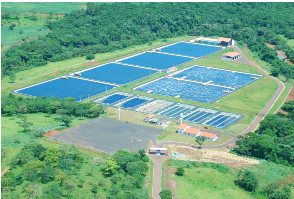
Imagen5 - Planta de Depuración Fuente: Codau, 2016
