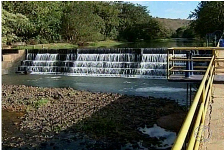
Imagen3 - Dique de contención de agua Fuente: Codau, 2016
