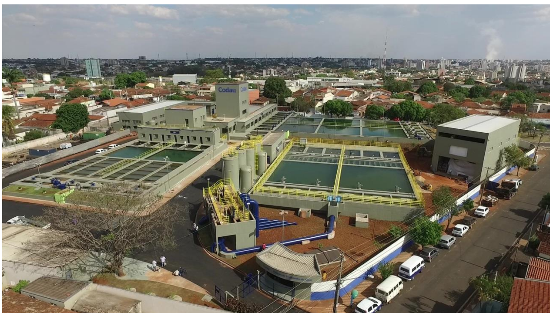
Imagen1 - Vista aérea de la Estación de Tratamiento de Agua
