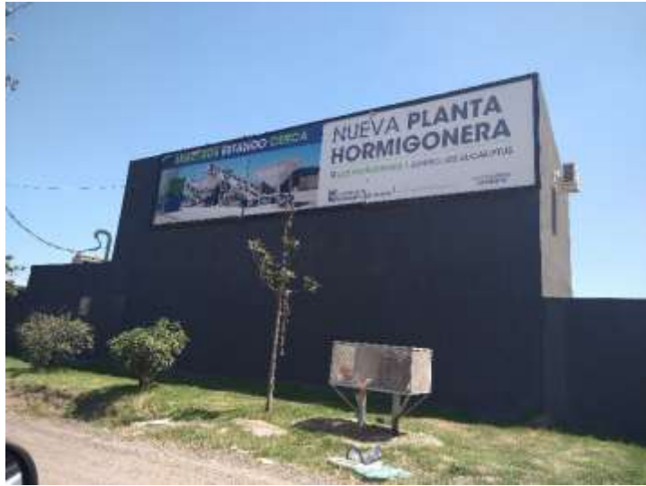
Imagen 1: Planta Hormigonera municipal sobre la calle Romain Rolland. Fuente: archivo propio (19 de diciembre de 2021).
