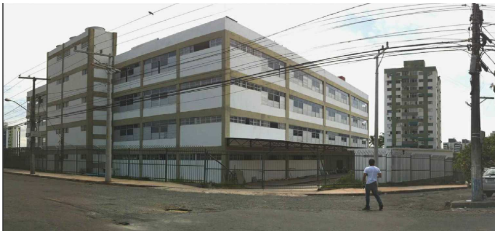
Figura 10. Antigua fachada del edificio
