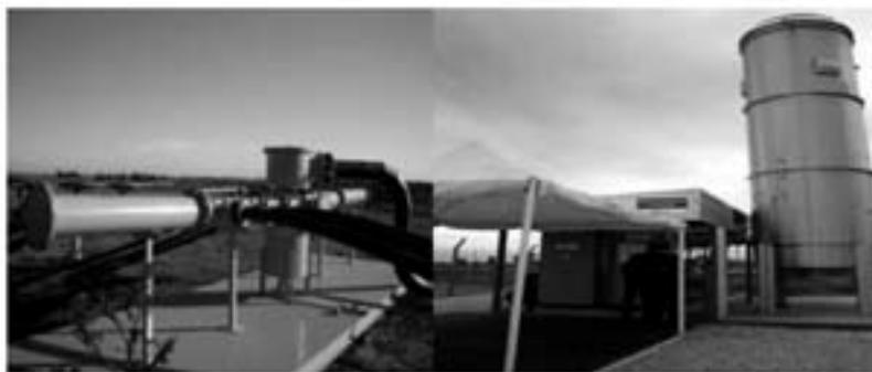
Figura 8. Extracción y conducción de gases y antorchas quemadoras.
