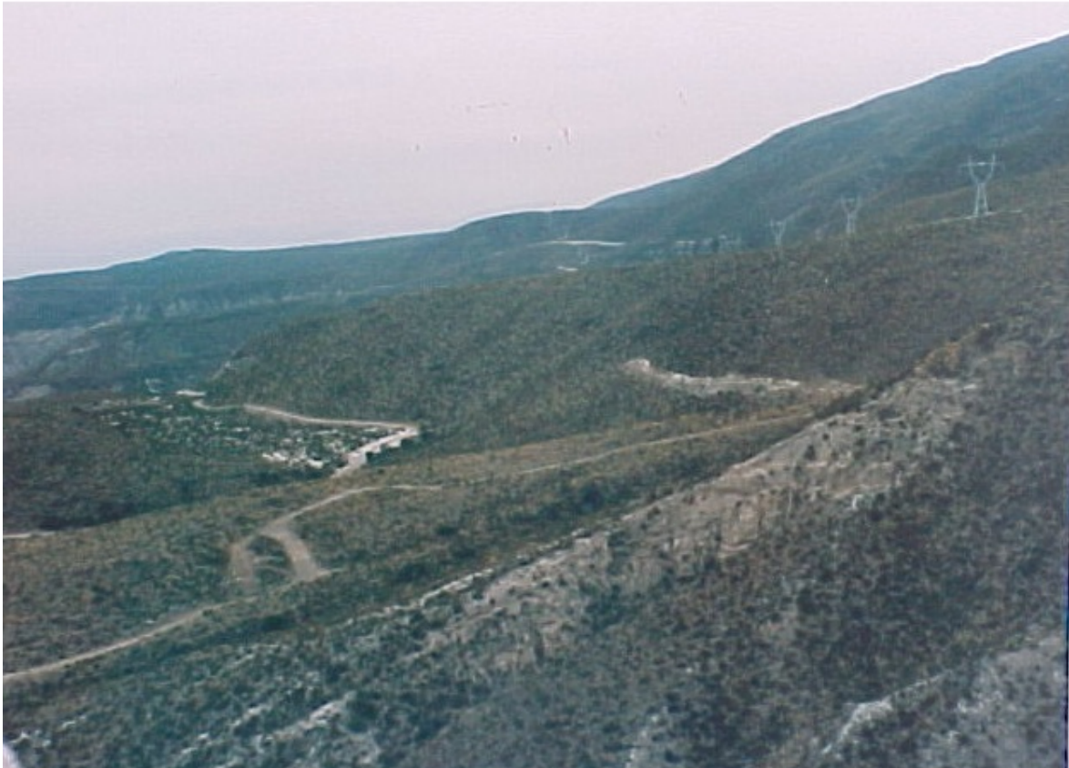
Foto 4.7 – Vista de acceso por zona de alta topografía relativa para acceder al tendido eléctrico que se desplaza por el sector alto.
