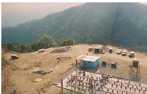
Foto 4.16 – Vista de obra civil de dimensión media (entre 1 a 2 ha)
