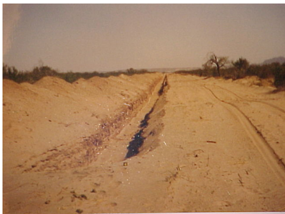
Foto 4.12 – Vista de pista (15 m), zanja (1 m) y sedimentos removidos por excavación
