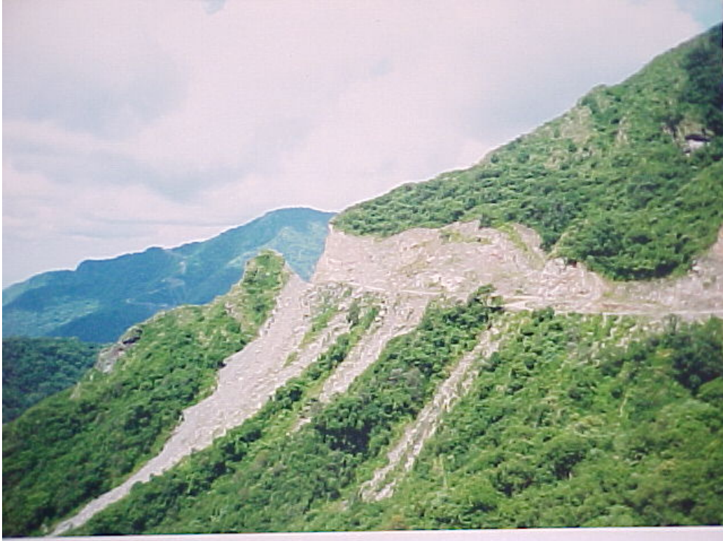
Foto 4.8 – Vista de acceso en área de alta topografía relativa
