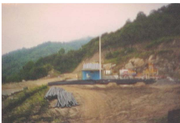
Foto 4.15 – Vista de obra civil de dimensión reducida (menos de 1 ha)
