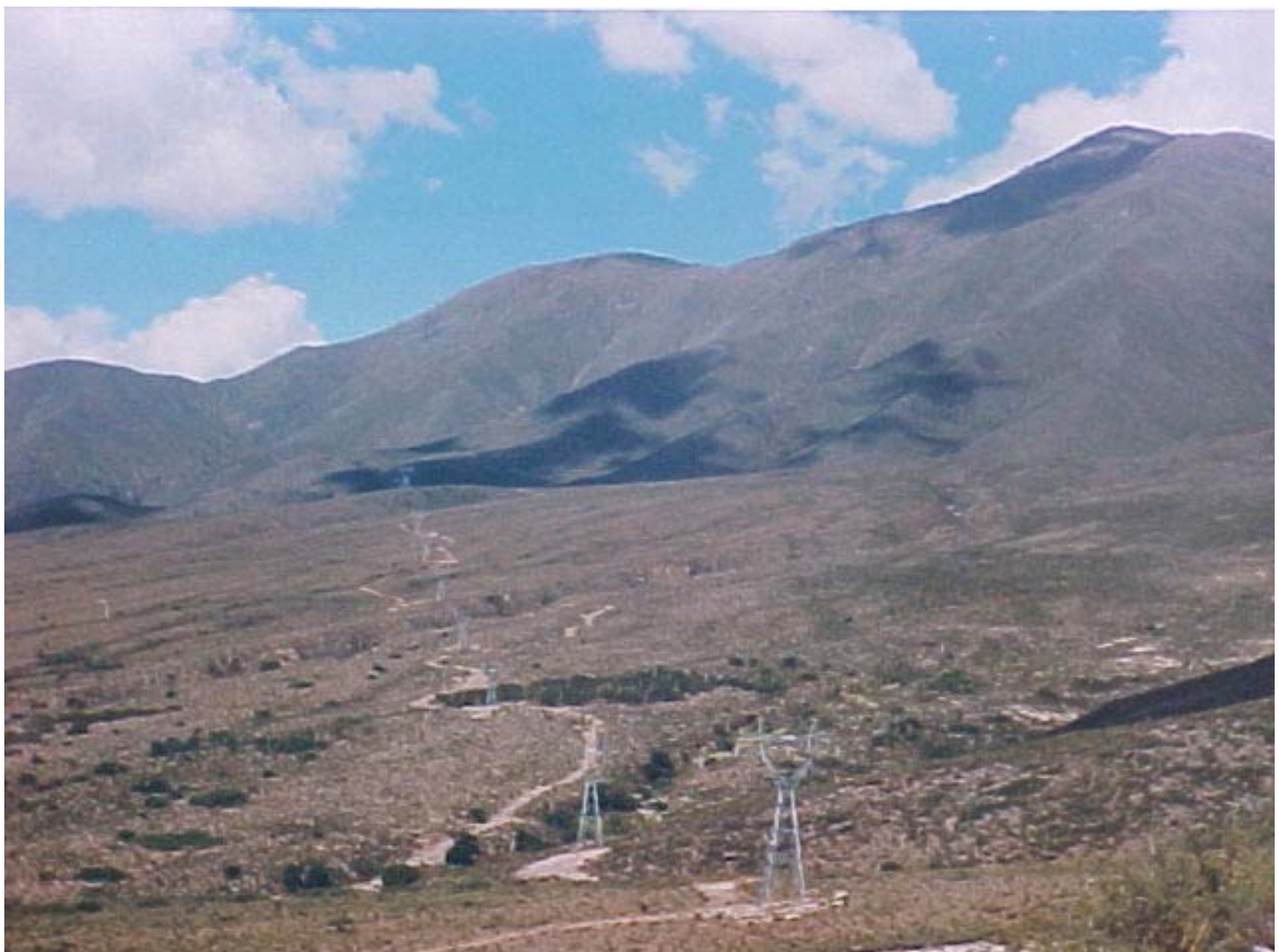
Foto 4.2. Vista del trazado lineal del tendido eléctrico de alta tensión
