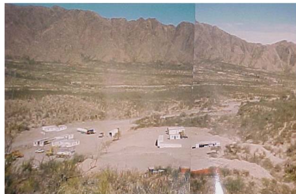
Foto 4.20 – Vista de área modificada para instalación de campamento temporario
