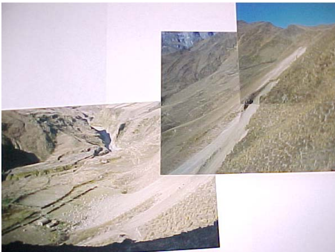
Foto 4.11 – Vista de desplazamiento de sedimentos y rocas por la ladera del cerro producto de la apertura de pista en el sector alto. Observar la afectación del puesto localizado en la base del cerro, tanto por sedimentos como piedras.
