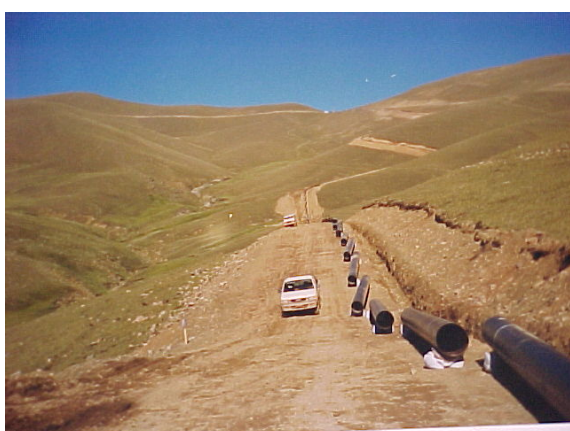
Foto 4.13 – Vista de pista, zanja y desfile de caños
