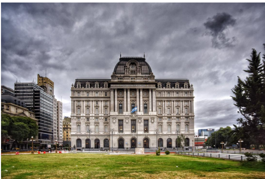
Ilustración 6. Edificio del ex Palacio de Correos. El edificio fue restaurado y, actualmente, funciona el Centro Cultural Kirchner. Adaptado del sitio en línea de la Ciudad de Buenos Aires.
