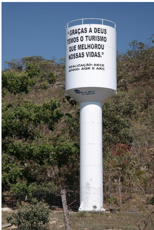
Figura 61 - Torre del agua y sus transcripciones asertivas sobre el turismo – Comunidad Engenho II – Quilombola-Kalunga – Cavalcante de Goiás-GO
