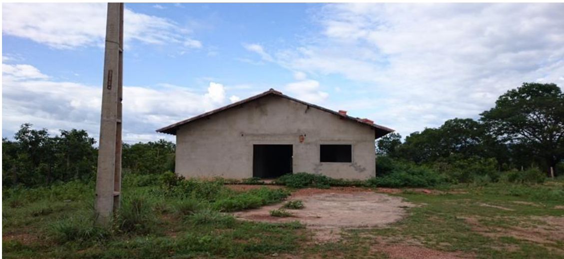
Figura 48 - Construção do Posto de Saúde para as Comunidades Quilombola-Kalunga: Limoeiro, Solidade, Ema, Abobreira, Diadema e Ribeirão. Obra interdita pelo Governo Federal- Município Teresina de Goiás/GO
