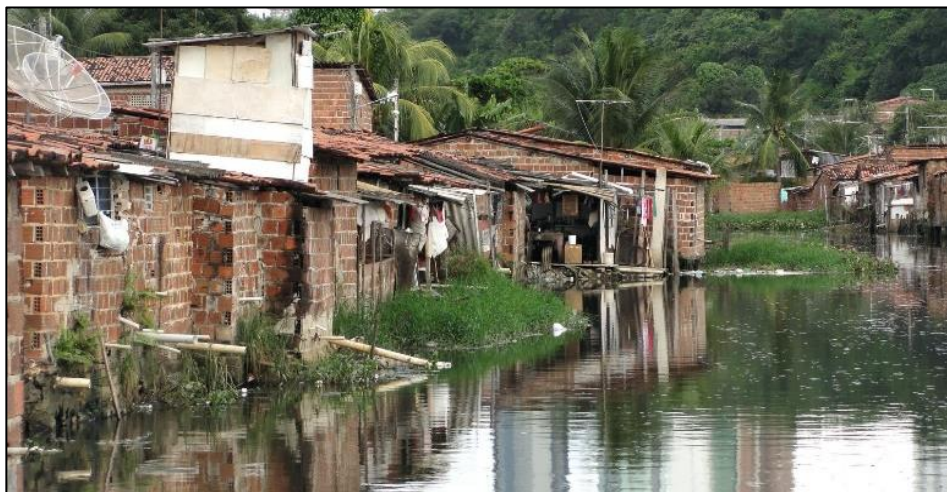
Foto 2: Alcantarillado canalizado hacia el río Jaguaribe debido a la falta de saneamiento básico. Fuente: https://www.clickpb.com.br/static/filebrowser/chuvassaojose.jpg
